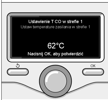
Zmiana temperatury ciepłej wody do ogrzewania
